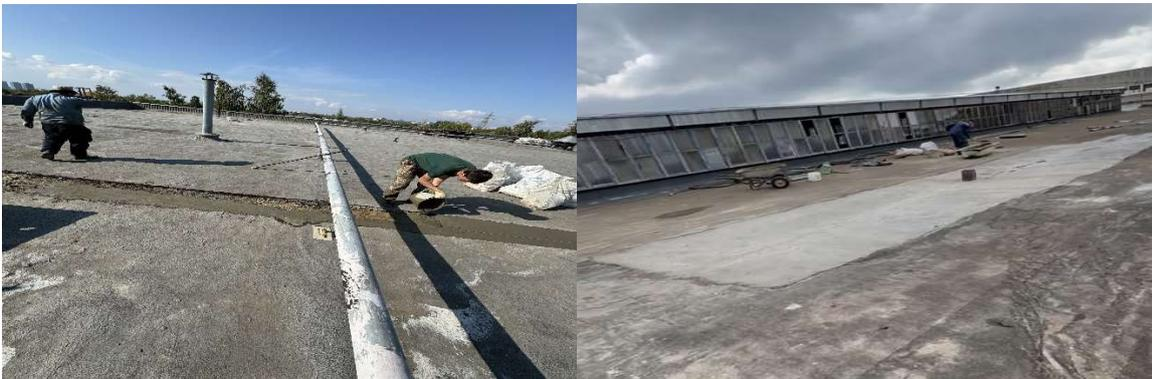
6. На стяжку наносится Вариант 1 (холодный способ-рекомендуется)-грунтовка Кольмат Адгезив, Вариант 2 (для горячего способа)-битумная грунтовка ПолиБитЭласт на основе органического растворителя, для лучшей адгезии мастики и рубероида со стяжкой (один-два слоя грунтовки в зависимости от пористости полученной стяжки, по 200 мл грунтовки на слой).
